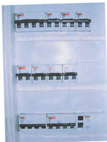
A megszakító véd a túlterhelés és rövidzárlat ellen.
