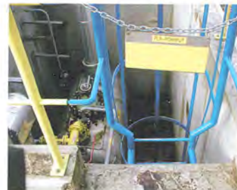
A szűk, zárt térségek bejárata gyakran szintén keskeny.
