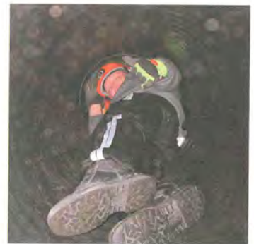
Egy esés ellen biztosító heveder szükséges olykor a zárt térbe való ki- és bejutáshoz.
